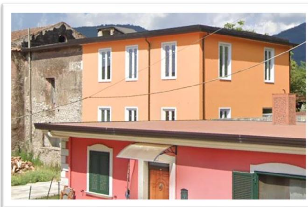
Foto post lavori
