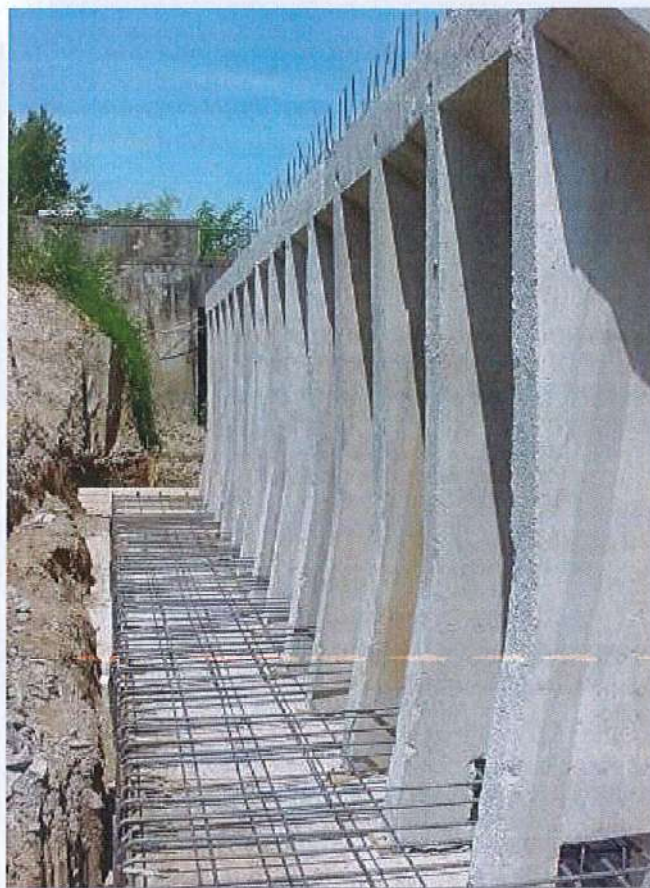
PONTE ORENTANO (PI) – FASE DI REALIZZAZIONE SPALLA IN C.A.P. SU MICROPALI
