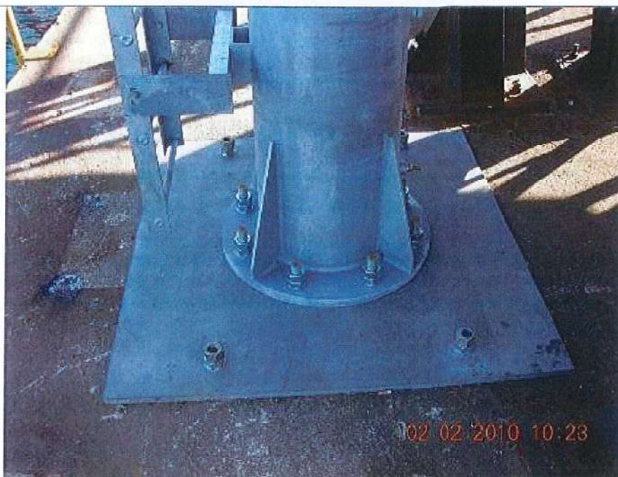
GAETA (LT) – PARTICOLARE STRUTTURA SPECIALE DI ANCORAGGIO IN ACCIAIO (ESTRADOSSO BANCHINA)
