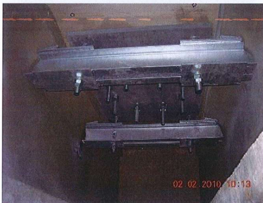
GAETA (LT) – PARTICOLARE STRUTTURA SPECIALE DI ANCORAGGIO IN ACCIAIO (INTRADOSSO BANCHINA)
